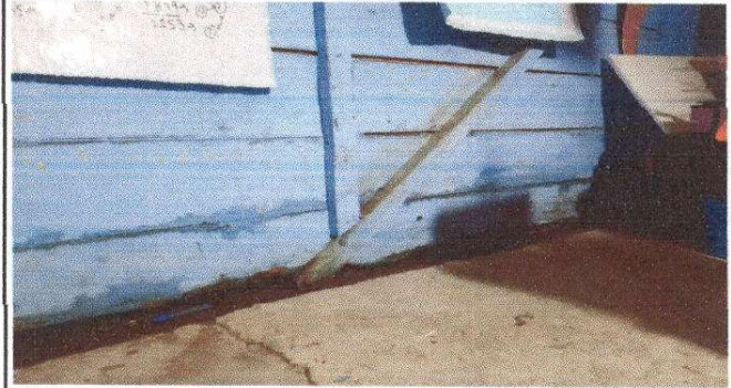
Foto 4: Sustitución de columnas de soporte de madera, por metal
